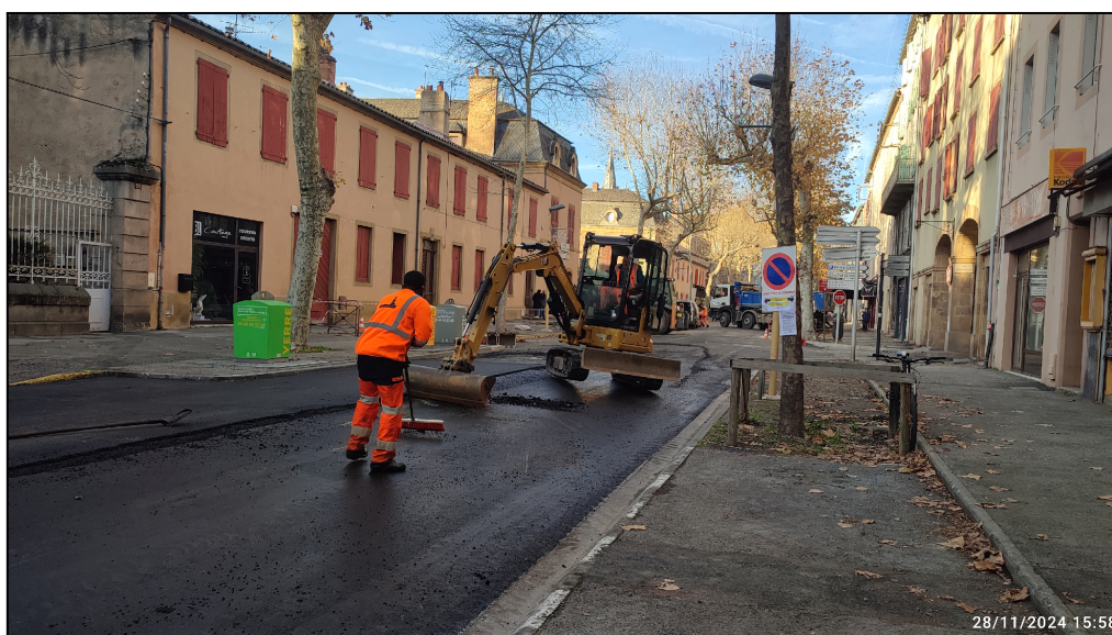
Illustration n°2 : photo du Boulevard de l'Ayrolle pendant la phase 2 des travaux
